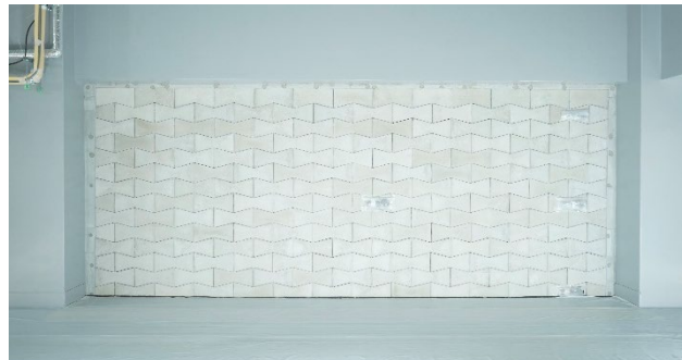
名古屋センタービルの適用状況
