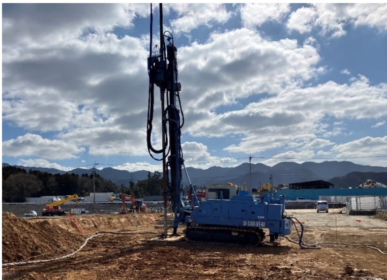
CUCO-CO 2 固定地盤改良の施工状況
