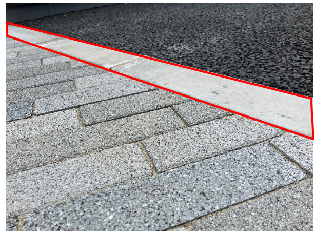
大阪・関西万博に適用したCUCO-舗装ブロック（左）ならびにCUCO-地先境界ブロック（右）
