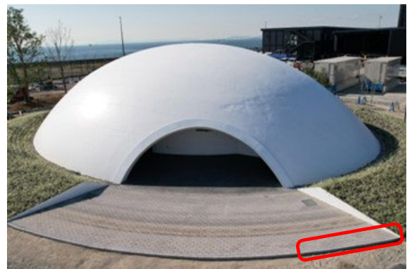
サステナドーム 舗装ブロック敷設箇所
