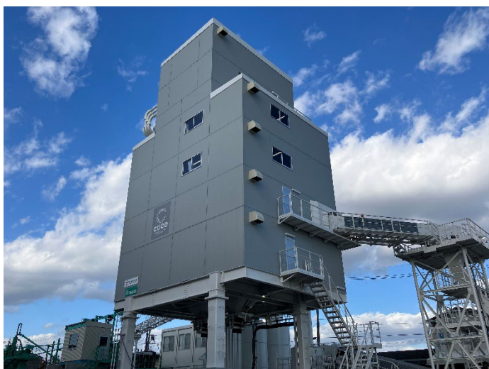
CUCO 加西実証プラント
