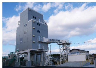
CUCO 加西実証プラント全景
